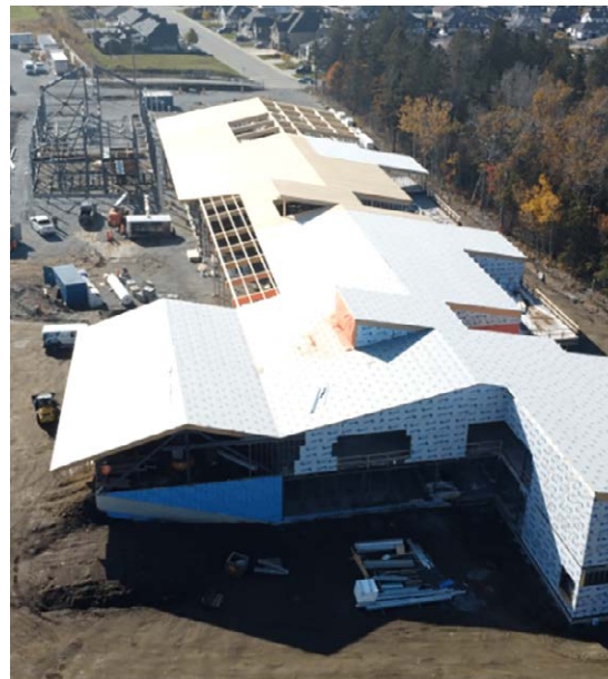
Chantier Lab-École Rimouski
