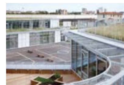
Des aménagements qui permettent un usage multifonctionnel de l'espace et qui facilitent la logistique de surveillance de la cour et des toitures. Rosalind Franklin School Complex, Chartier Dalix Architectes, France, 2015
