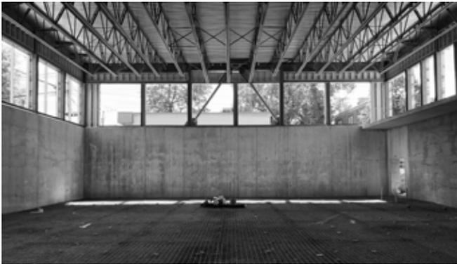
Le béton des fondations restera apparent dans le gymnase.
